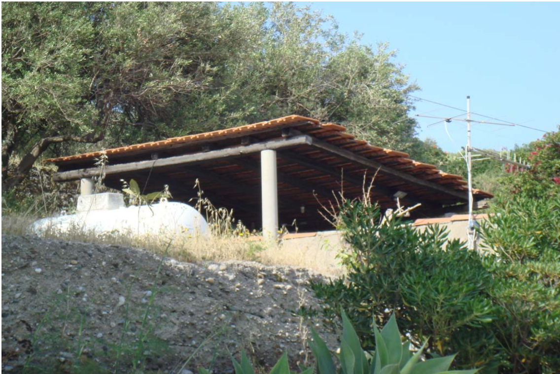
FOTO VISTA LATO S (S330)
