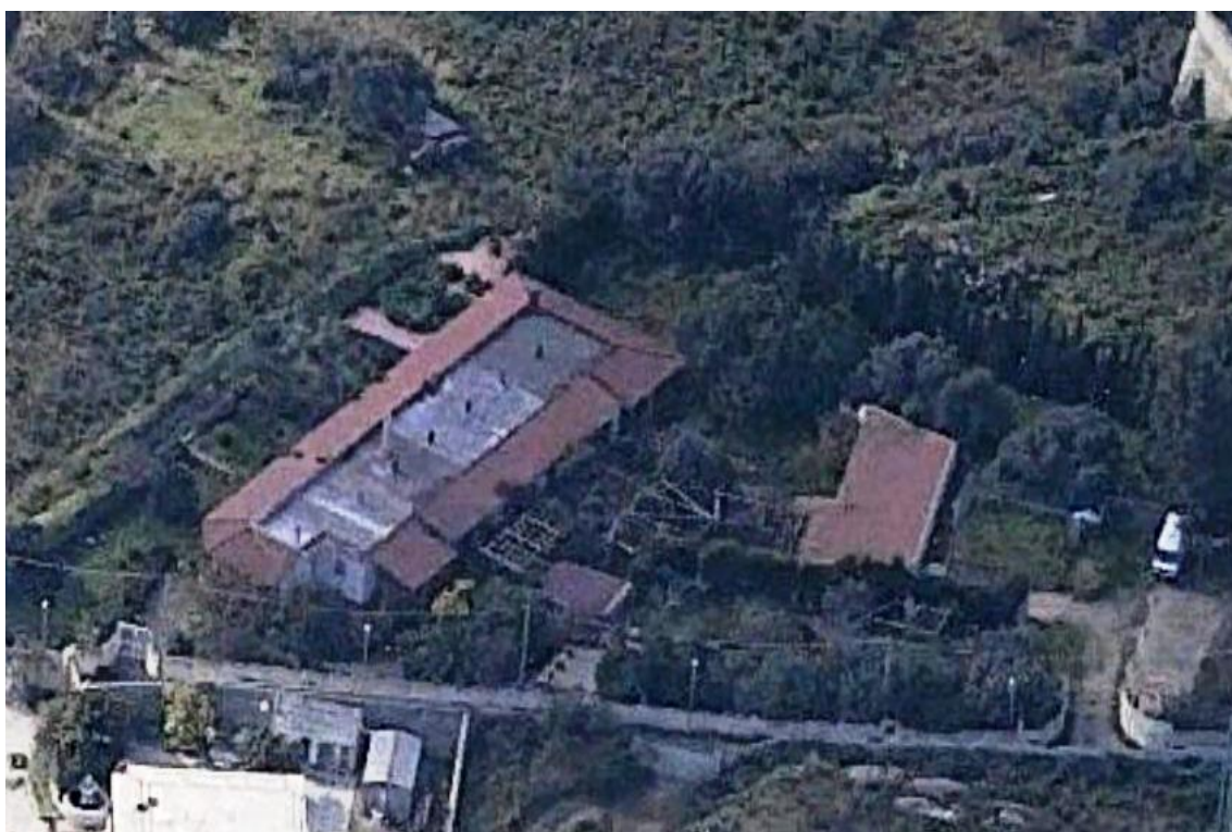
FOTO VISTA LATO NORD
