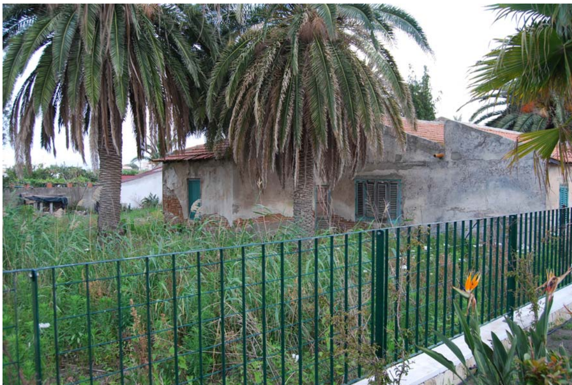
FOTO VISTA LATO NORD
