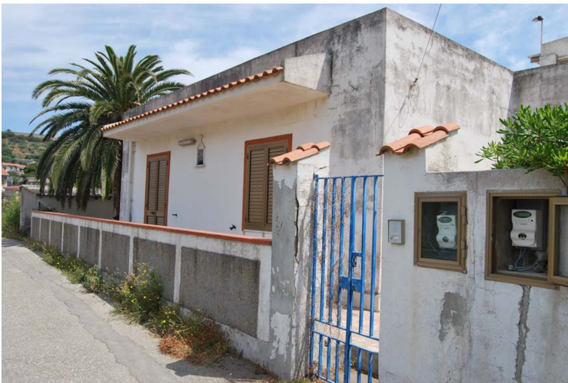
FOTO VISTA LATO S/O
