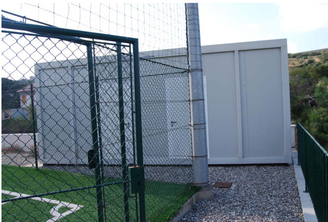
FOTO VISTA SUD - FABB. S172
