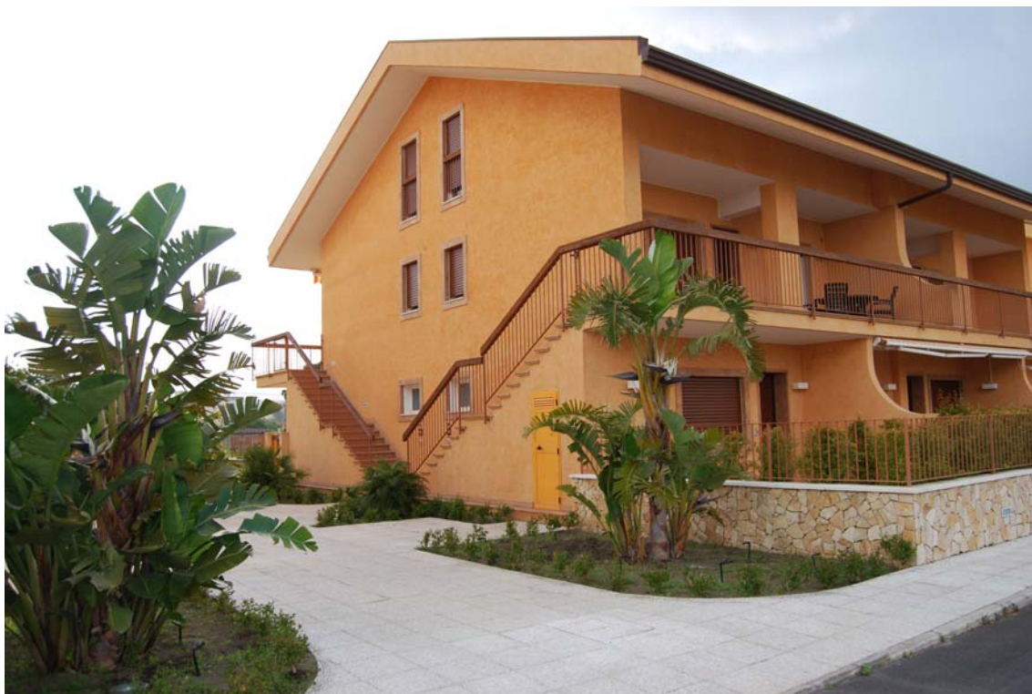
FOTO VISTA SUD/E - FABB. S183
