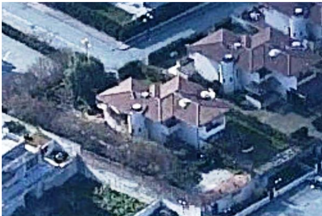
FOTO VISTA LATO N/E
