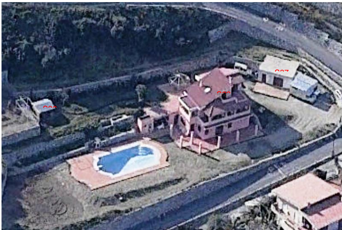
FOTO VISTA LATO NORD
