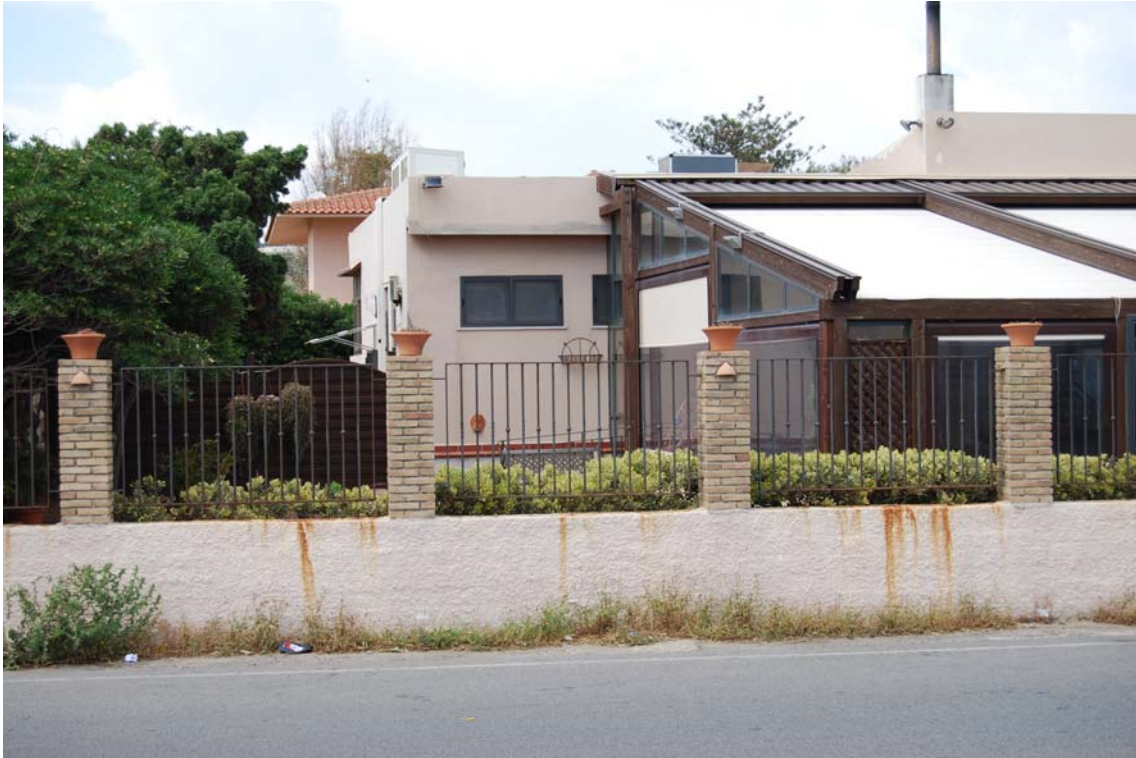
FOTO VISTA LATO SUD/OVEST
