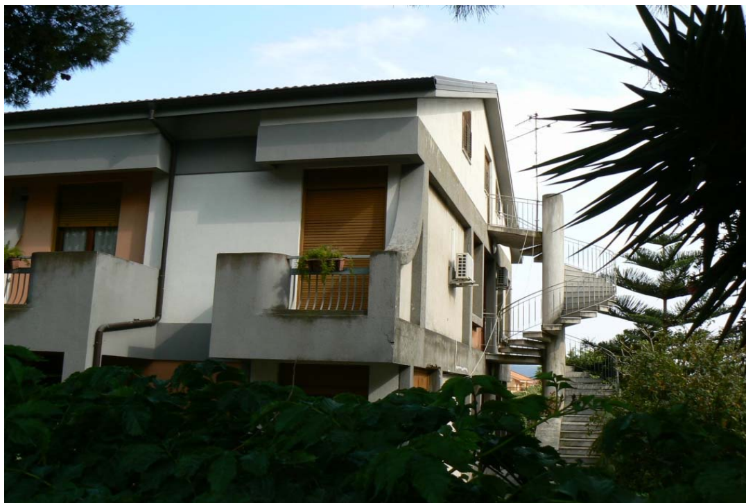
FOTO VISTA LATO NORD/OVEST
