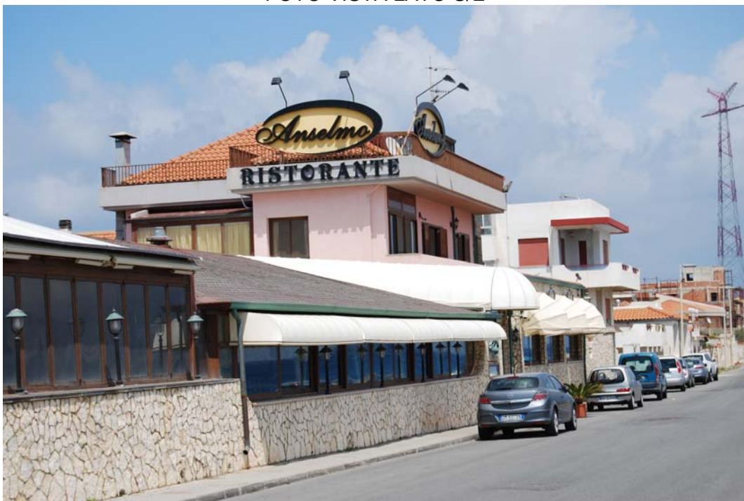
FOTO VISTA LATO S/O
