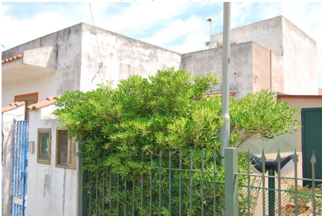
FOTO VISTA LATO S/O
