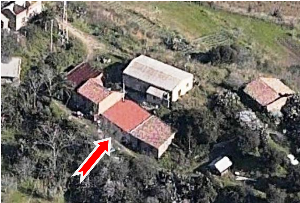
FOTO VISTA LATO S/O
