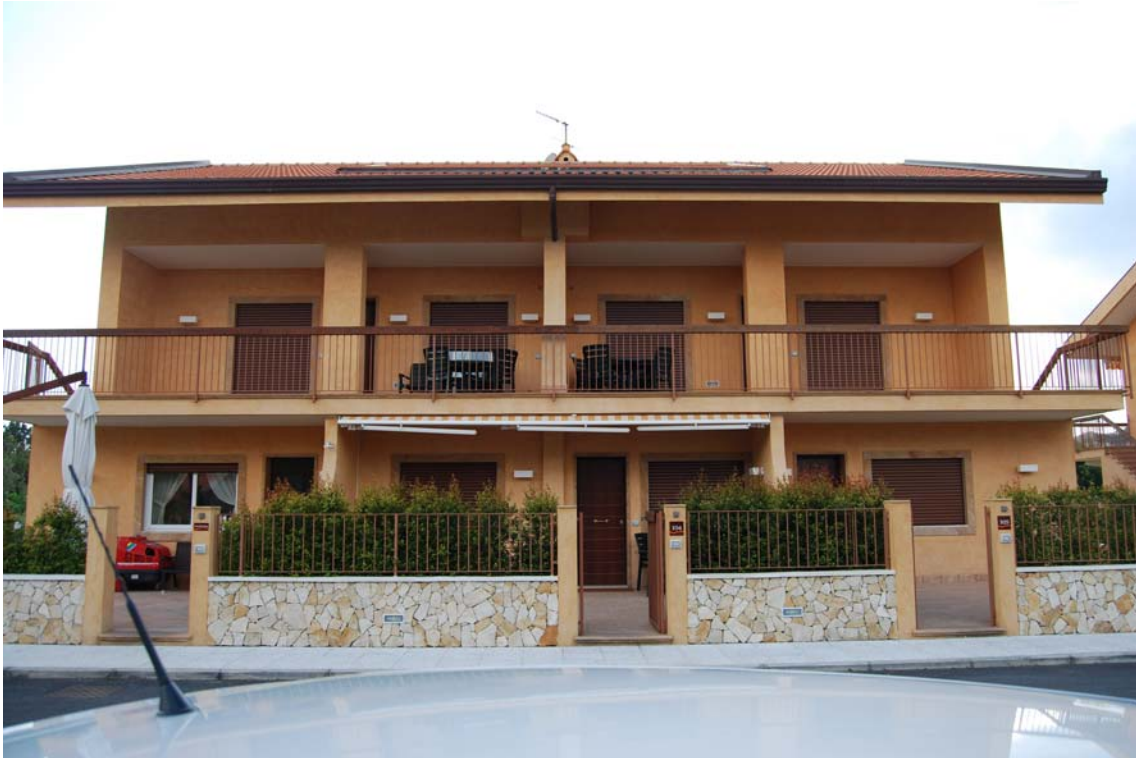
FOTO VISTA EST - FABB. S186
