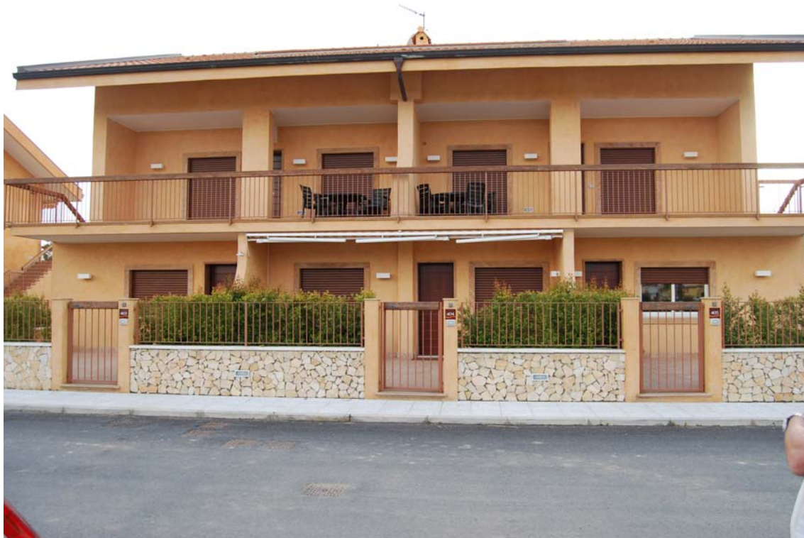
FOTO VISTA EST - FABB. S184
