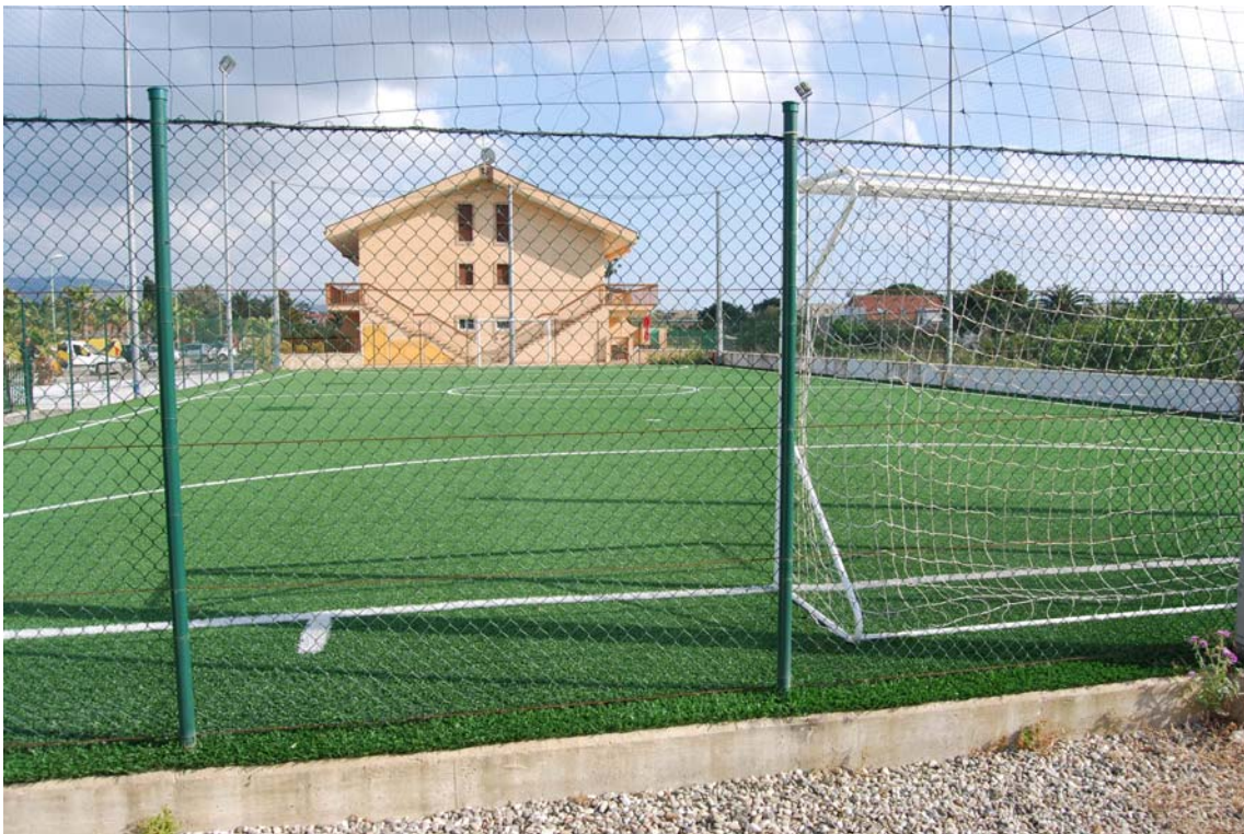
FOTO VISTA NORD - FABB. S177
