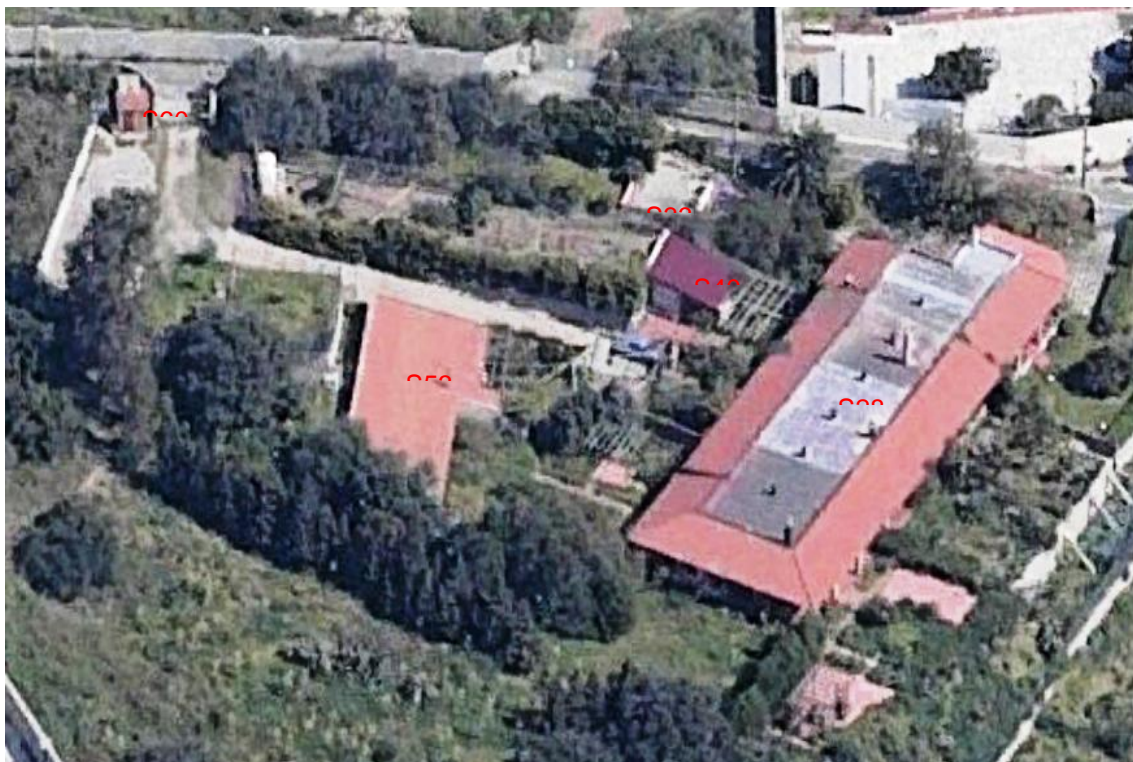
FOTO VISTA LATO SUD
