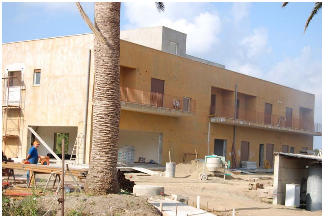
FOTO VISTA LATO SUD/OVEST
