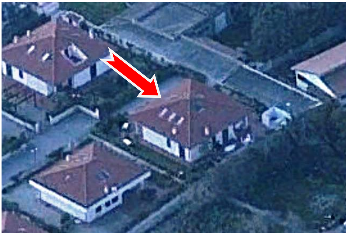
FOTO VISTA LATO NORD/EST
