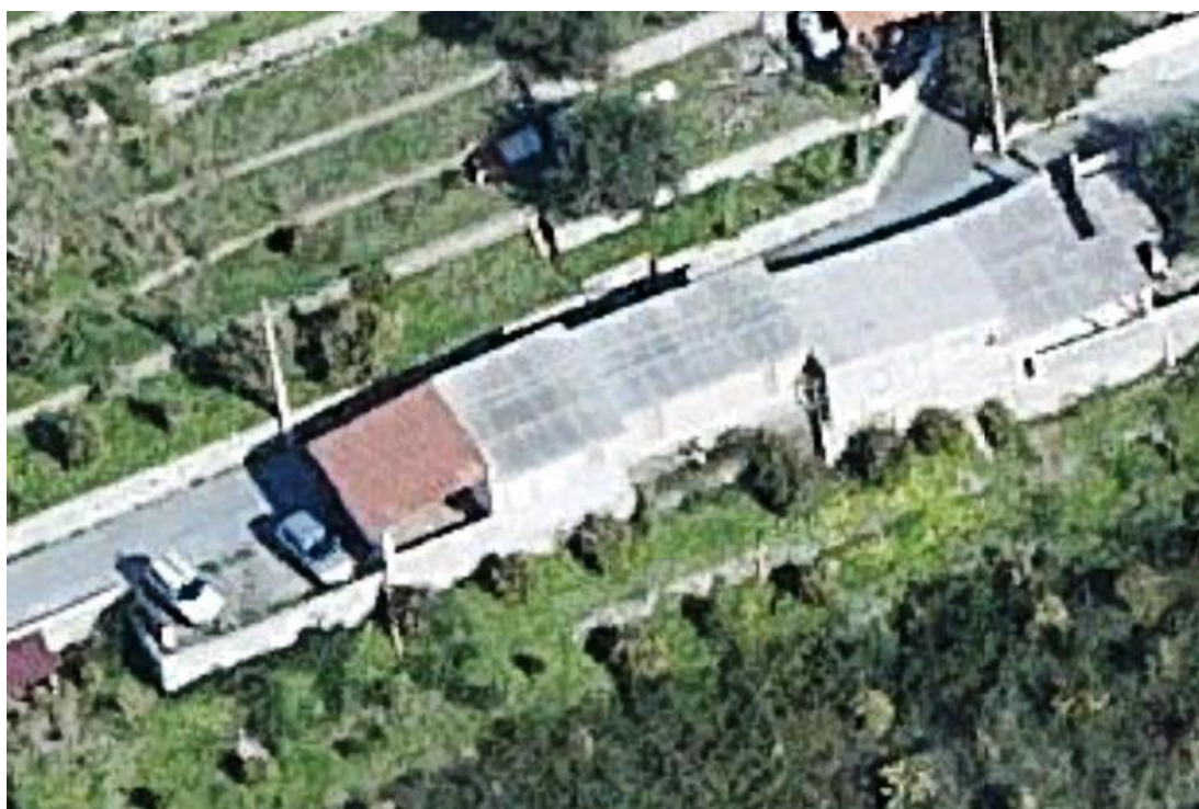
FOTO VISTA LATO SUD
