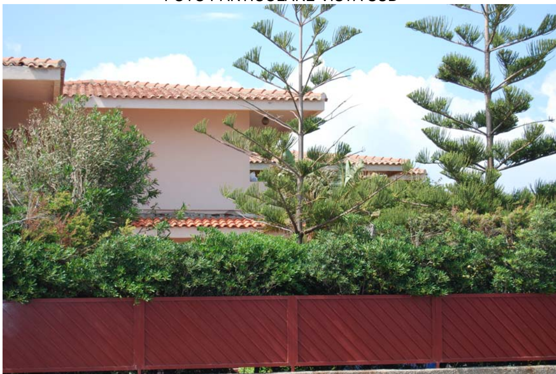
FOTO PARTICOLARE VISTA SUD
