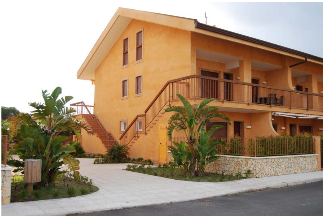
FOTO VISTA SUD/E - FABB. S182
