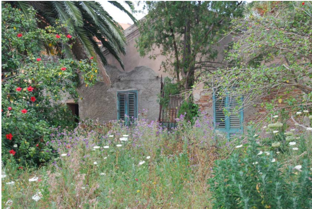
FOTO VISTA LATO SUD
