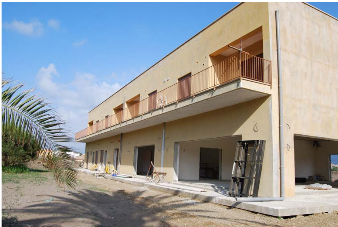
FOTO VISTA LATO SUD
