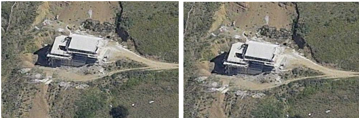
FOTO VISTA NORD/O e VISTA SUD/E
