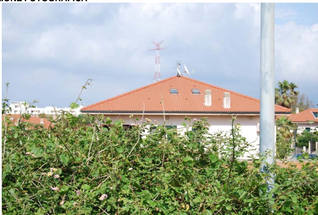
FOTO VISTA LATO NORD
