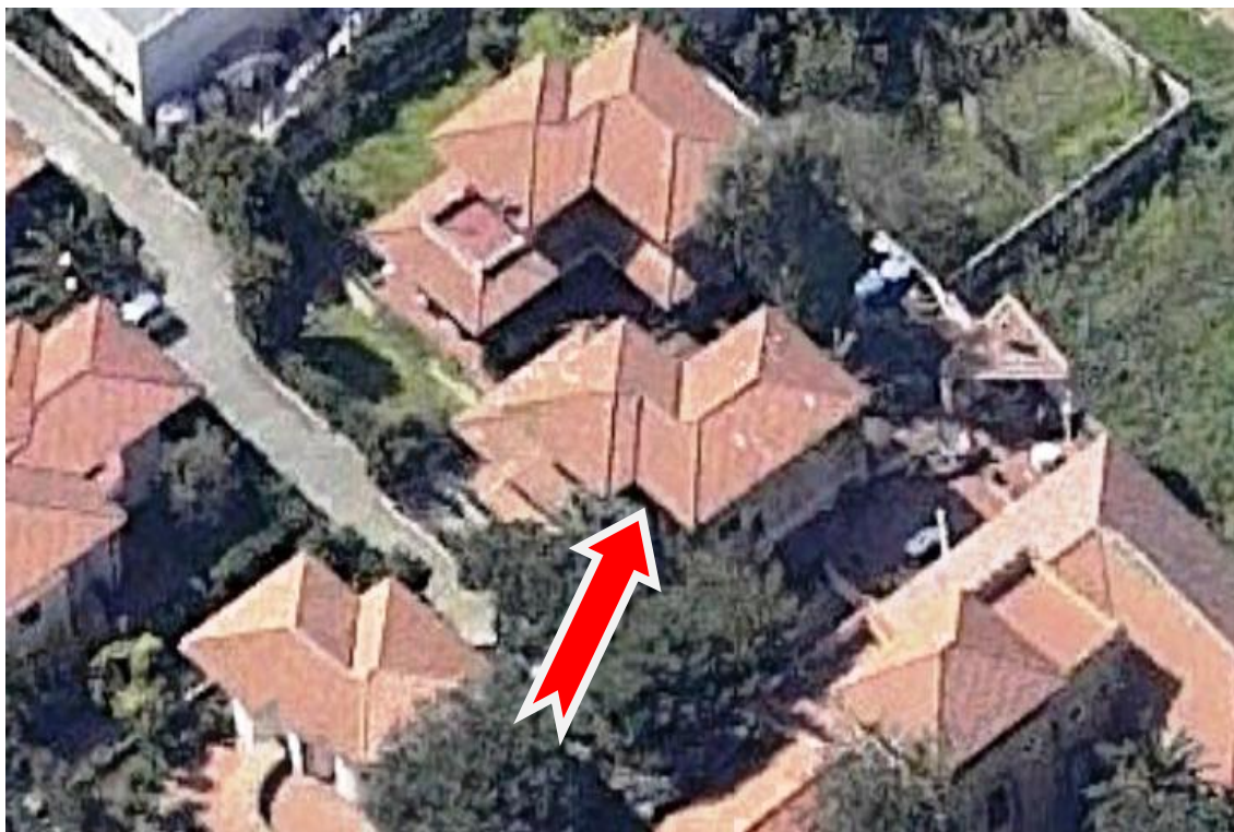
FOTO VISTA LATO NORD/EST
