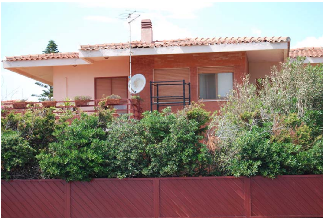
FOTO PARTICOLARE VISTA SUD
