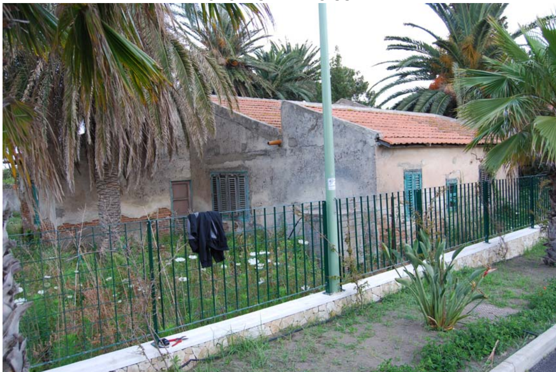
FOTO VISTA LATO NORD/OVEST
