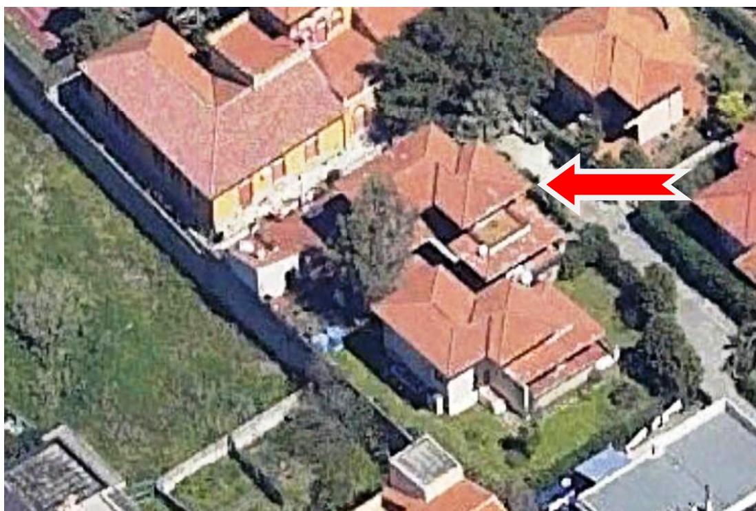
FOTO VISTA LATO SUD/OVEST
