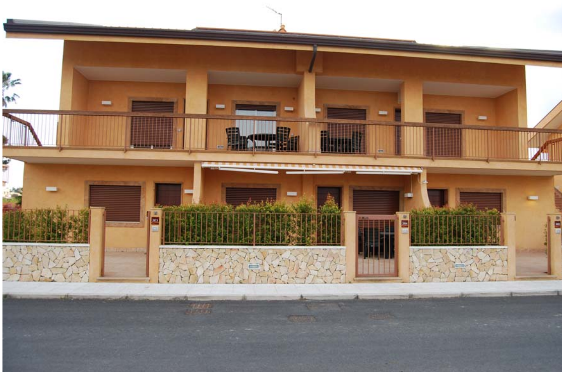
FOTO VISTA EST - FABB. S183
