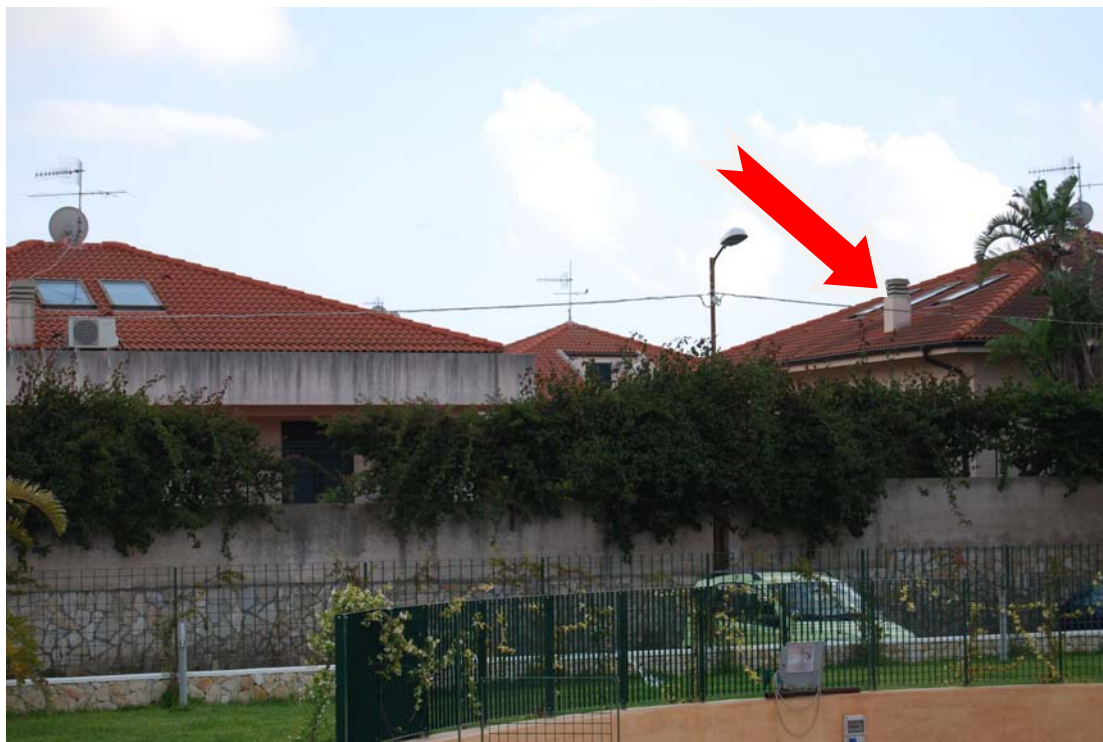
FOTO VISTA LATO NORD
