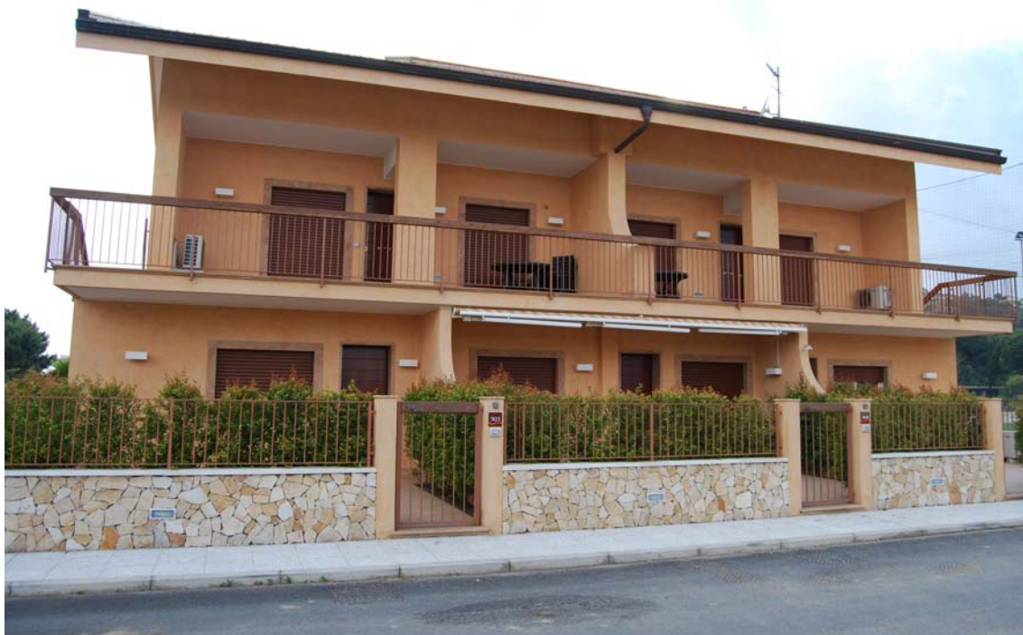
FOTO VISTA EST - FABB. S185
