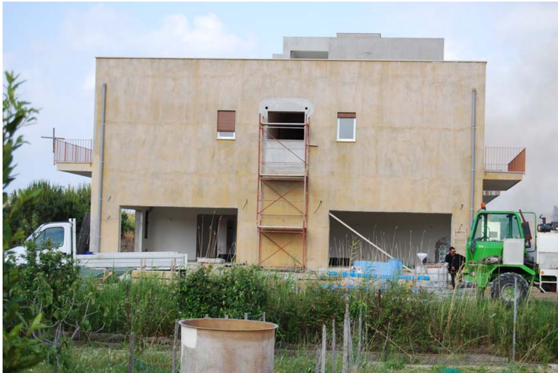
FOTO VISTA LATO OVEST
