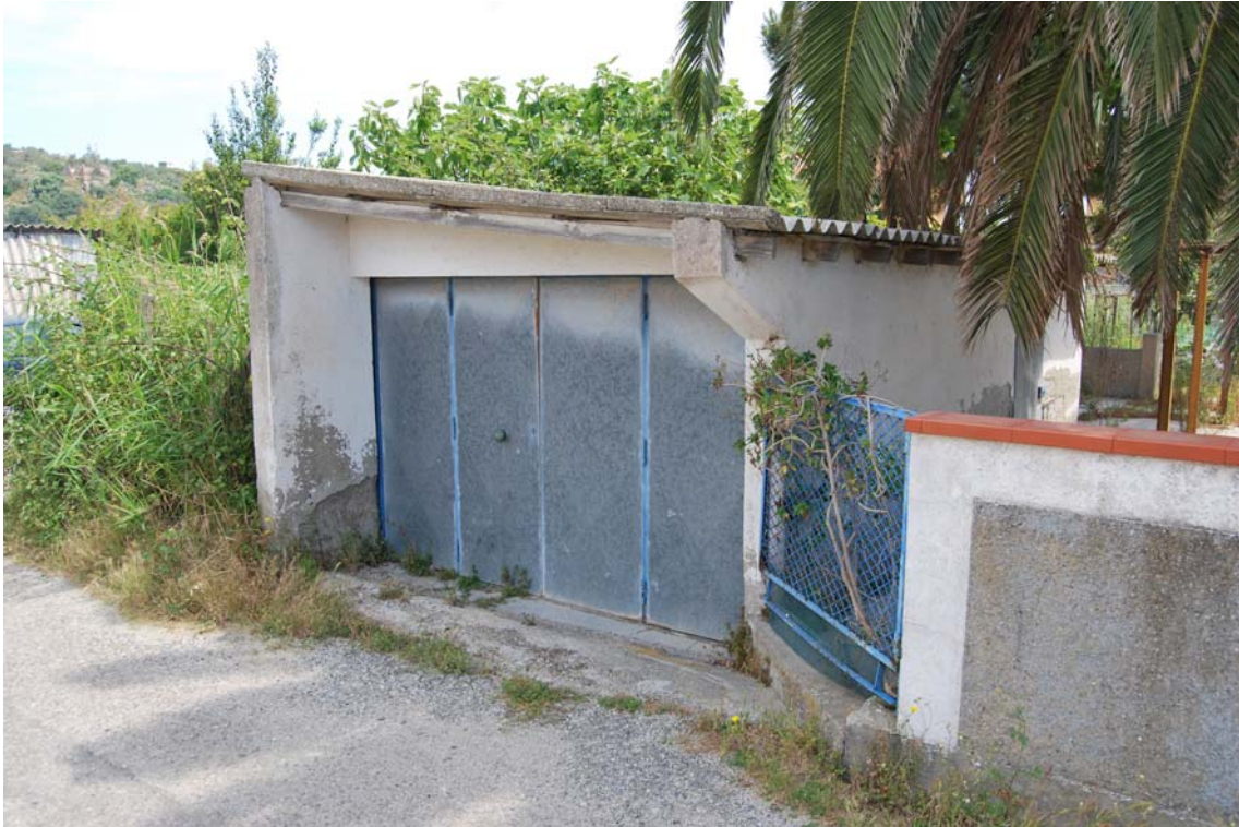
FOTO VISTA LATO O (S284)
