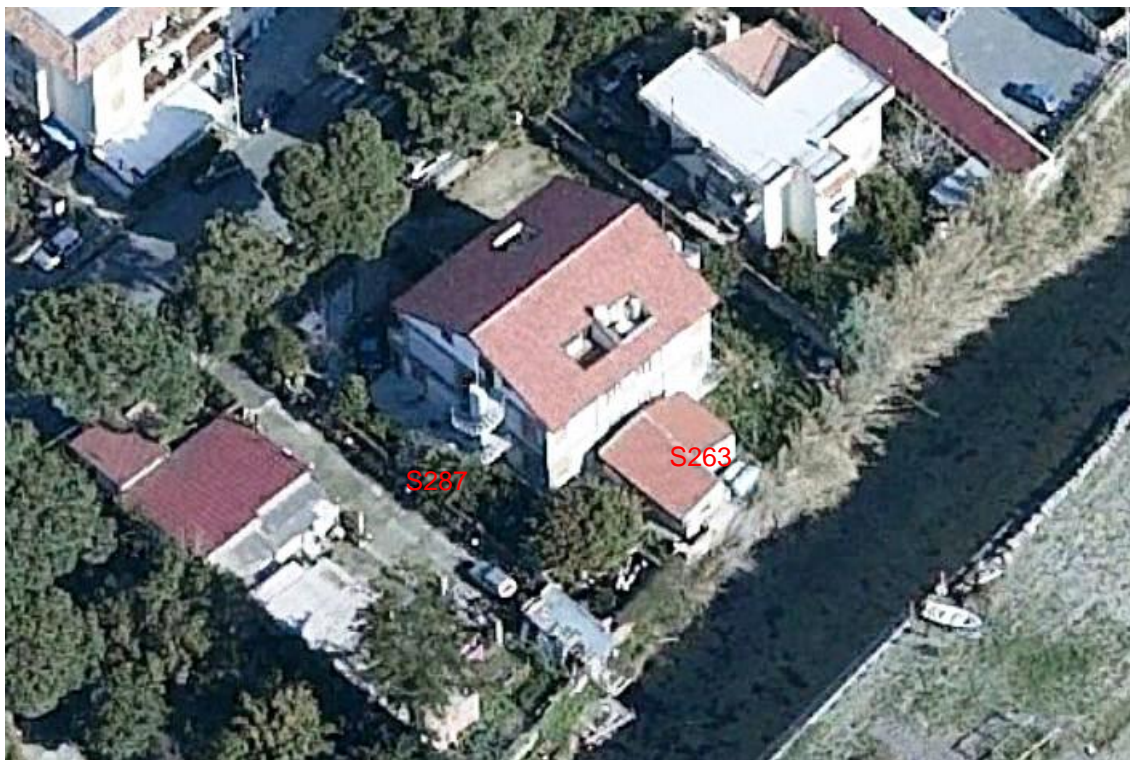
FOTO VISTA LATO SUD/OVEST
