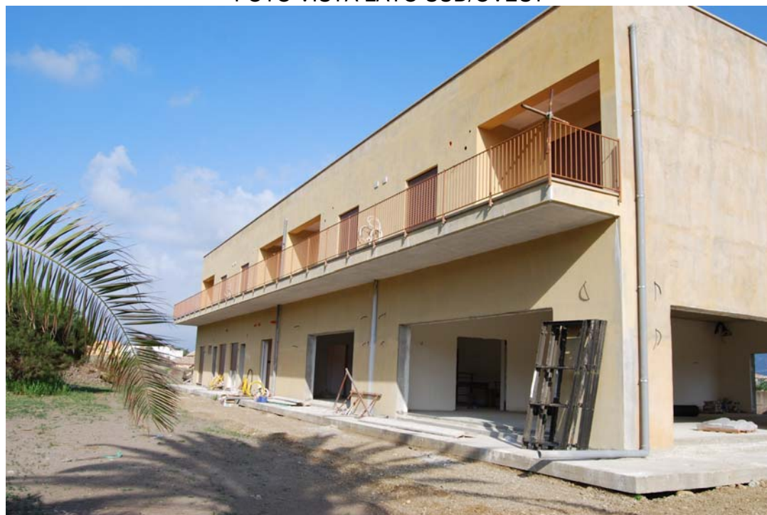
FOTO VISTA LATO SUD
