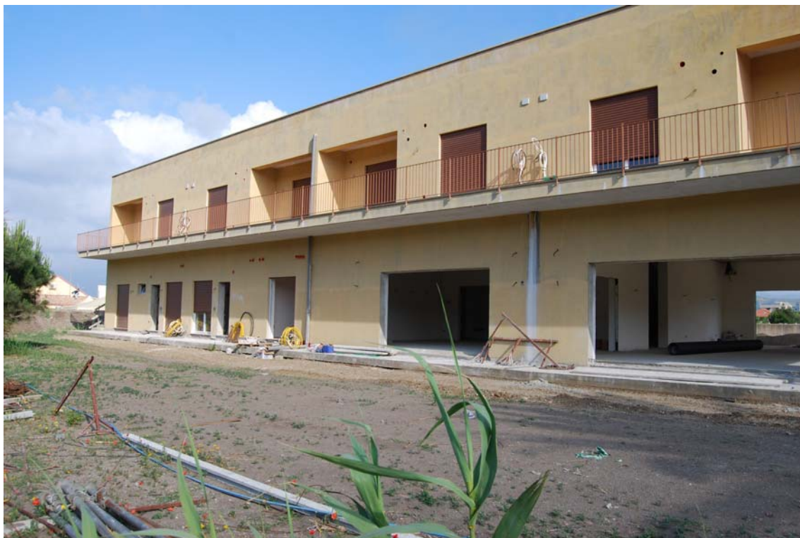
FOTO VISTA LATO SUD
