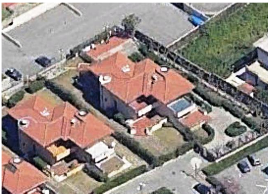
FOTO VISTA LATO S/O
