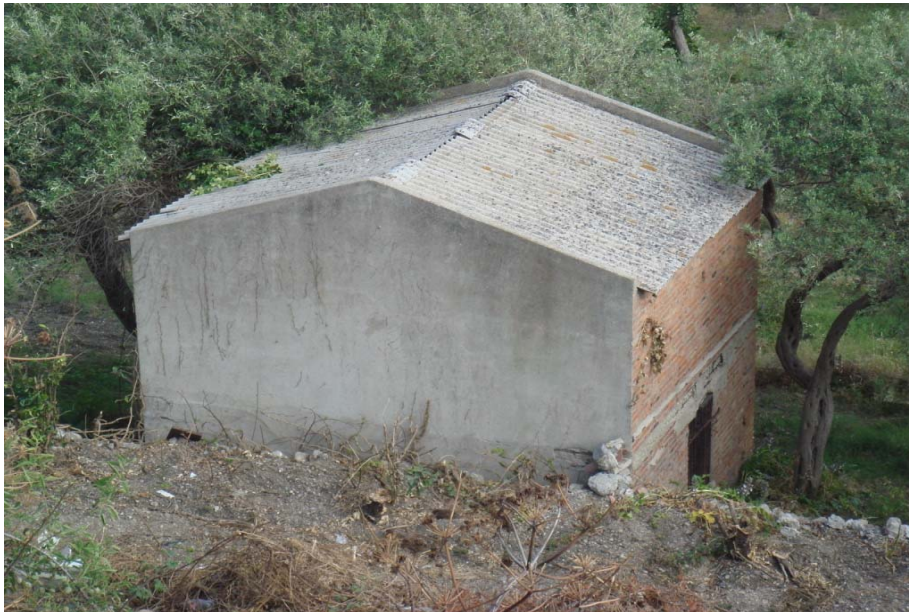
FOTO VISTA LATO SUD
