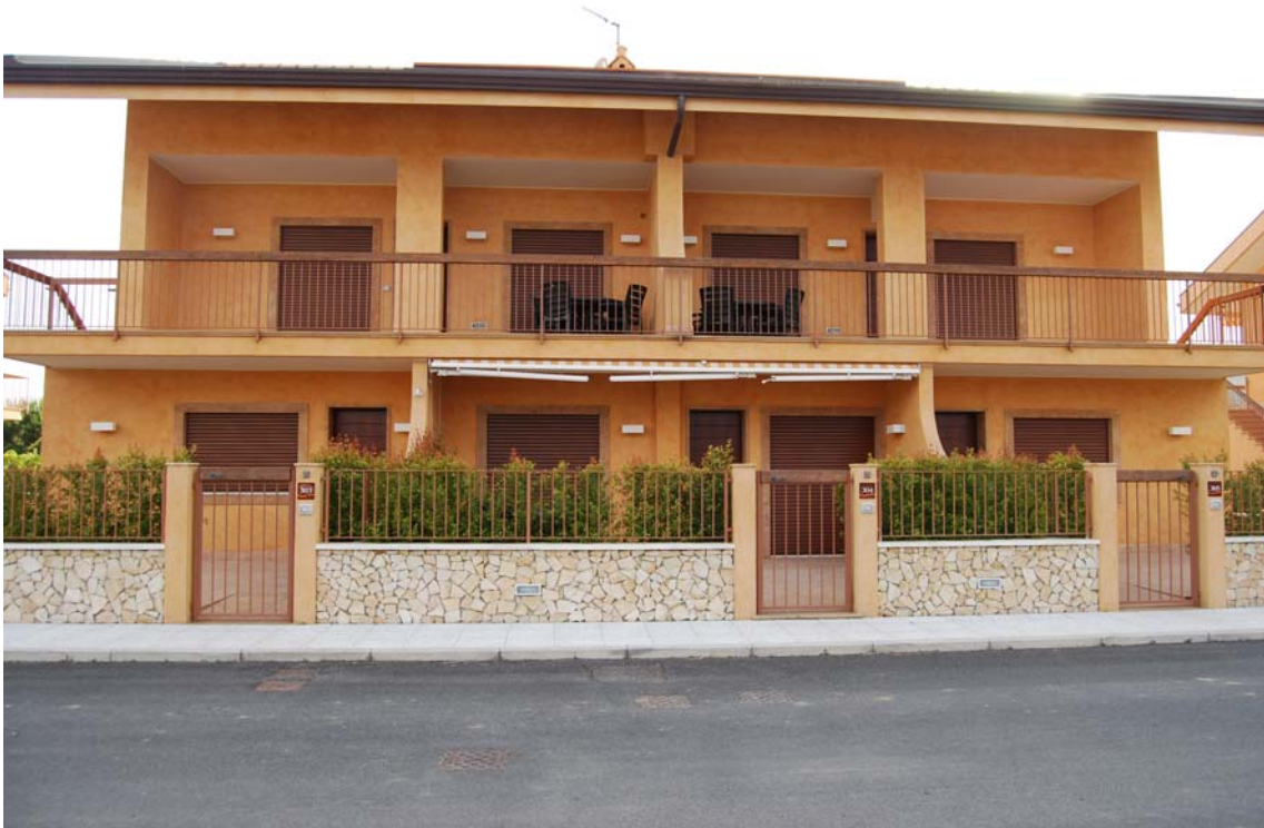
FOTO VISTA EST - FABB. S182
