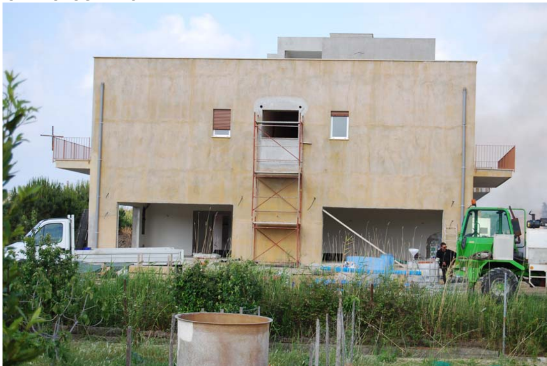
FOTO VISTA LATO OVEST
