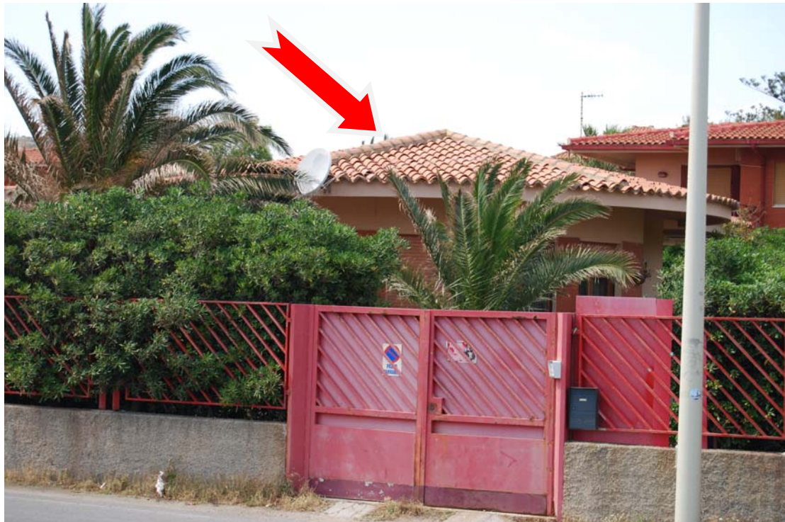
FOTO PARTICOLARE VISTA SUD
