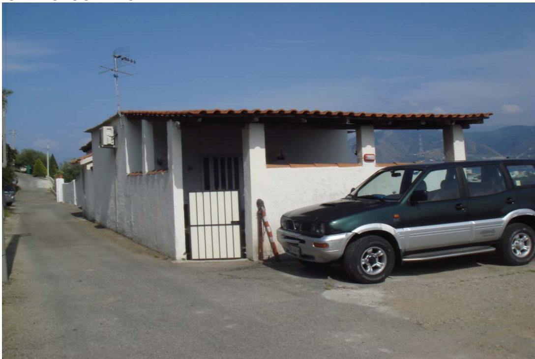
FOTO VISTA LATO OVEST
