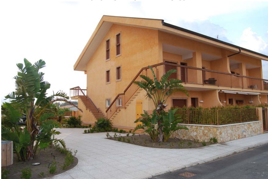
FOTO VISTA SUD/E - FABB. S185
