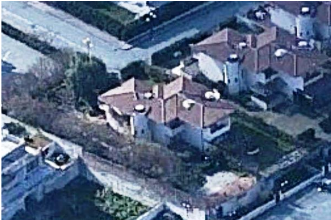
FOTO VISTA LATO N/E
