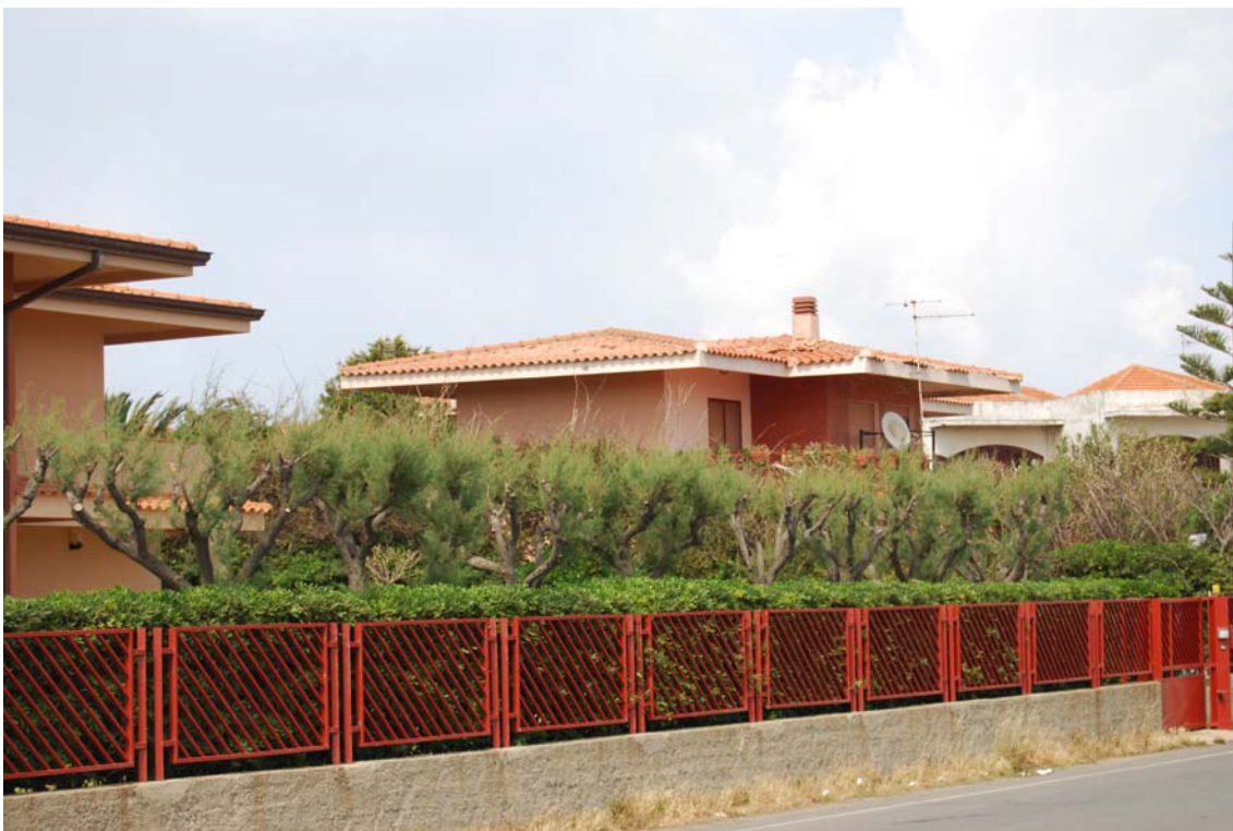
FOTO VISTA SUD OVEST
