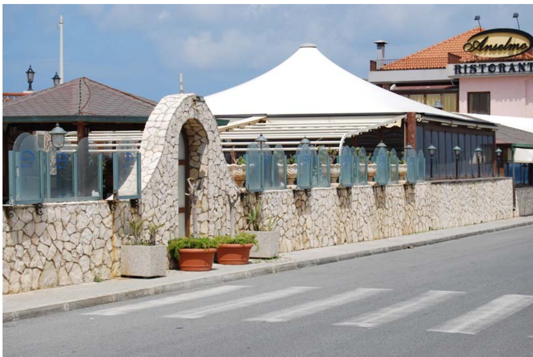
FOTO VISTA LATO S/O
