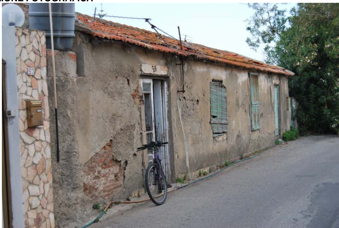
FOTO VISTA LATO S/O
