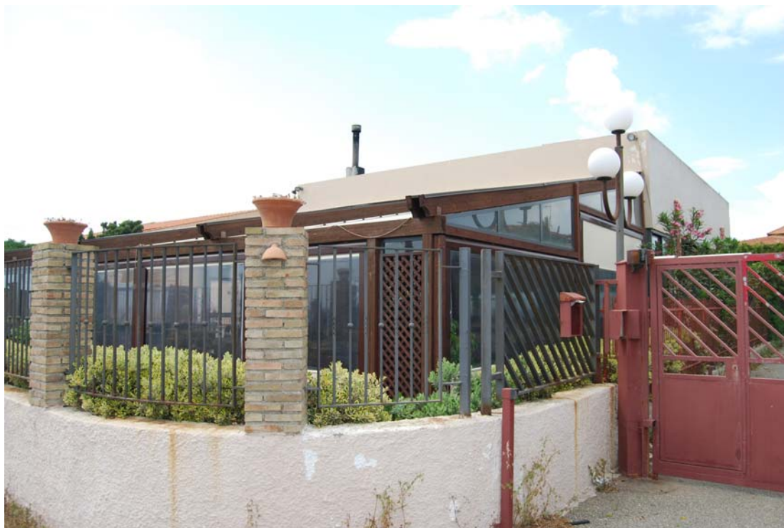
FOTO VISTA LATO SUD/EST
