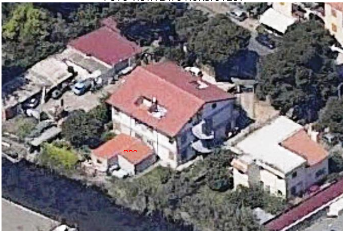
FOTO VISTA LATO SUD/EST
