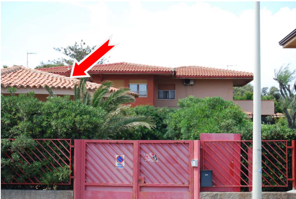
FOTO PARTICOLARE VISTA SUD
