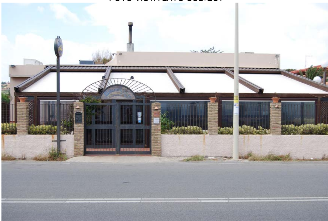
FOTO VISTA LATO SUD
