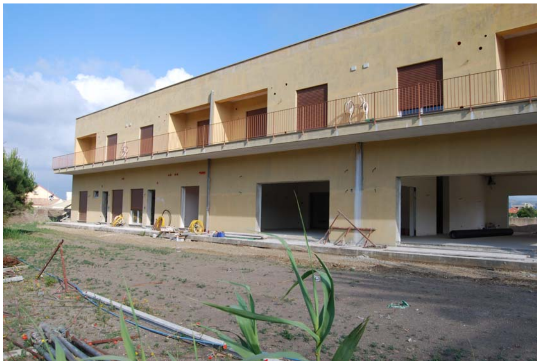
FOTO VISTA LATO SUD
