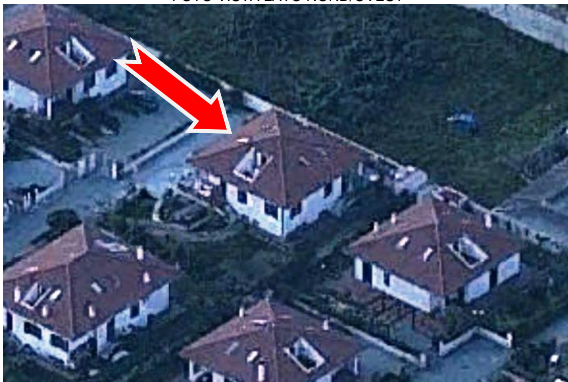
FOTO VISTA LATO NORD/EST
