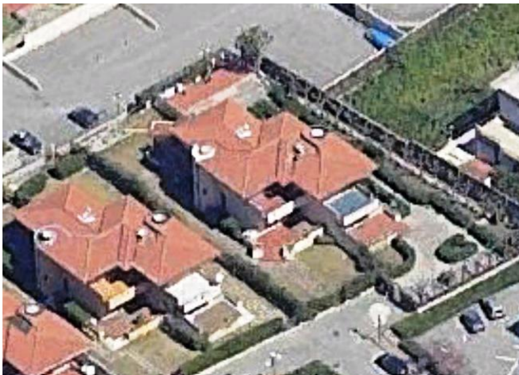
FOTO VISTA LATO S/O
