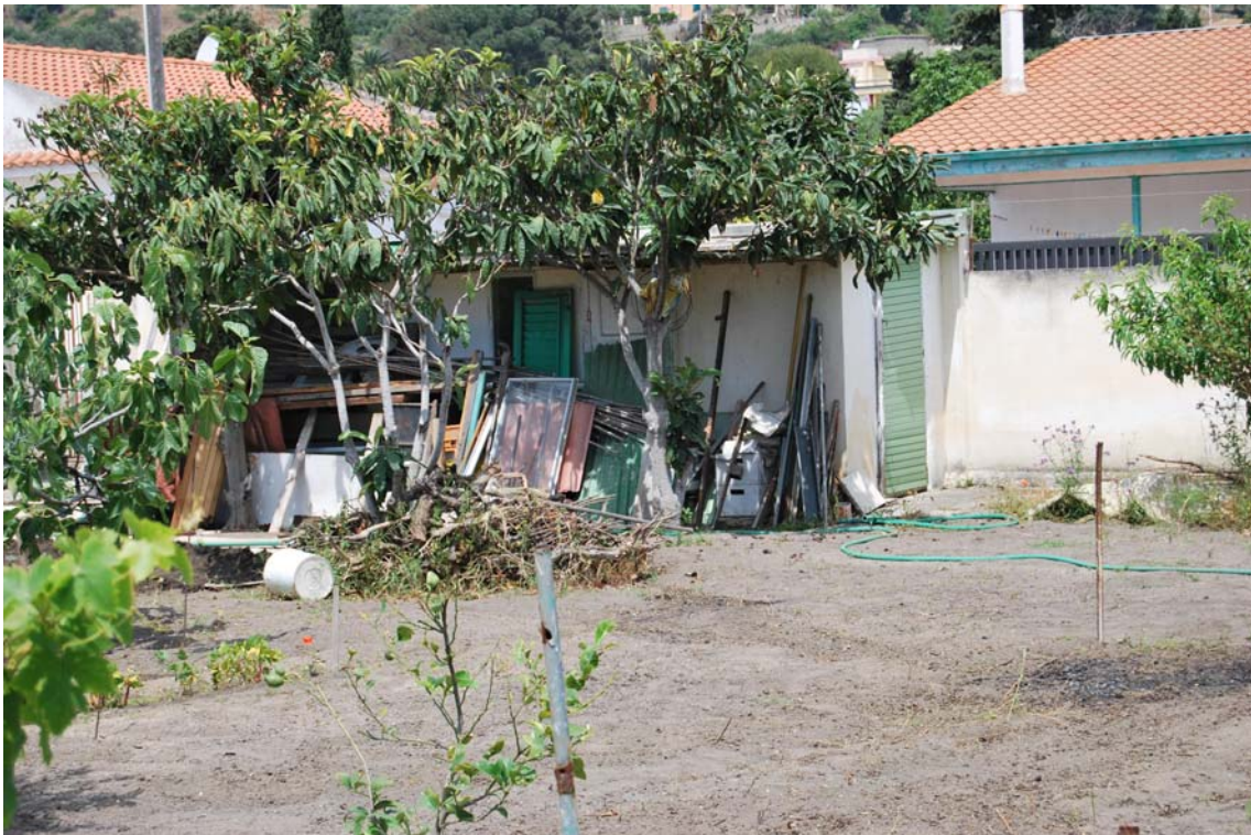
FOTO VISTA SUD (S326)
