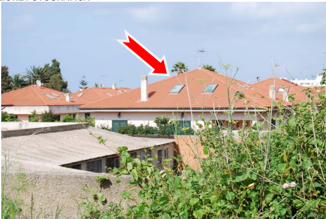
FOTO VISTA LATO NORD
