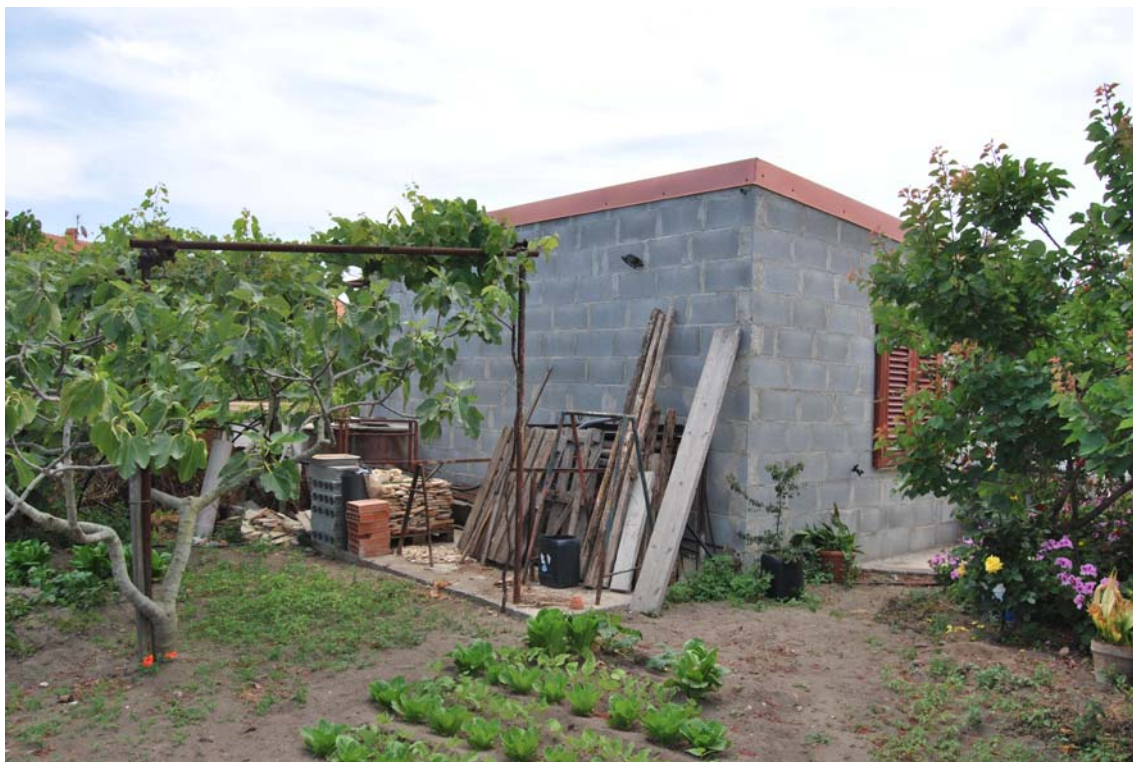
FOTO LATO OVEST (GARAGE S273)
