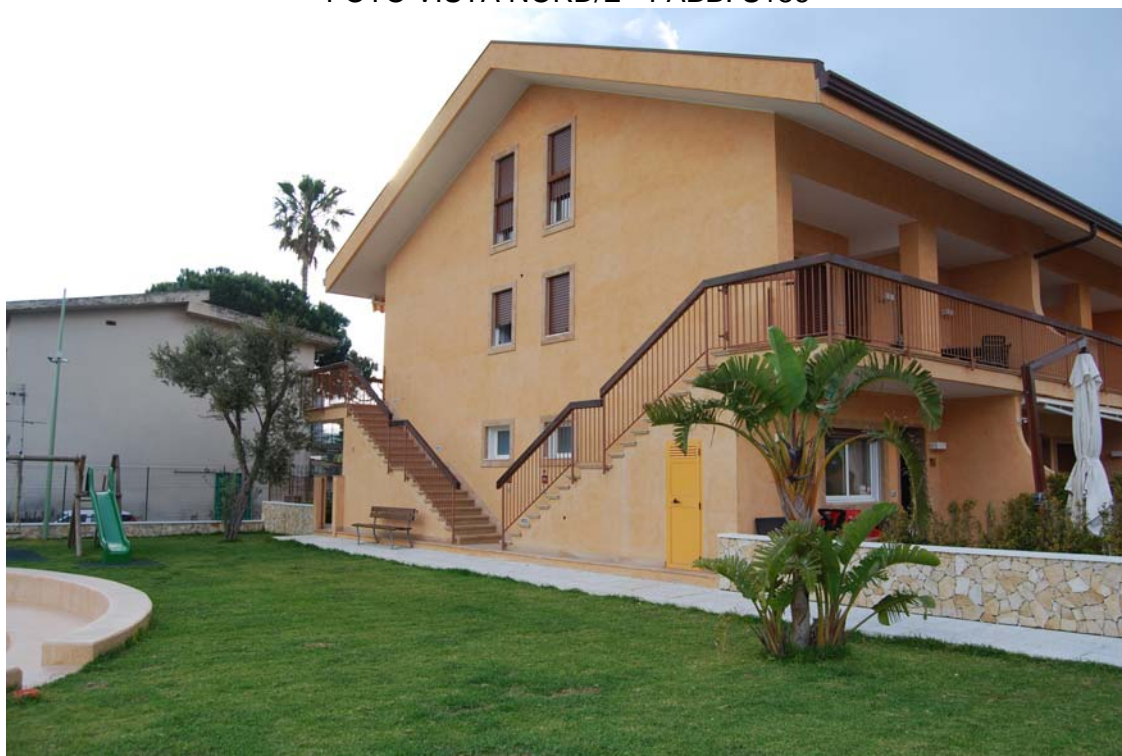
FOTO VISTA SUD/E - FABB. S186
