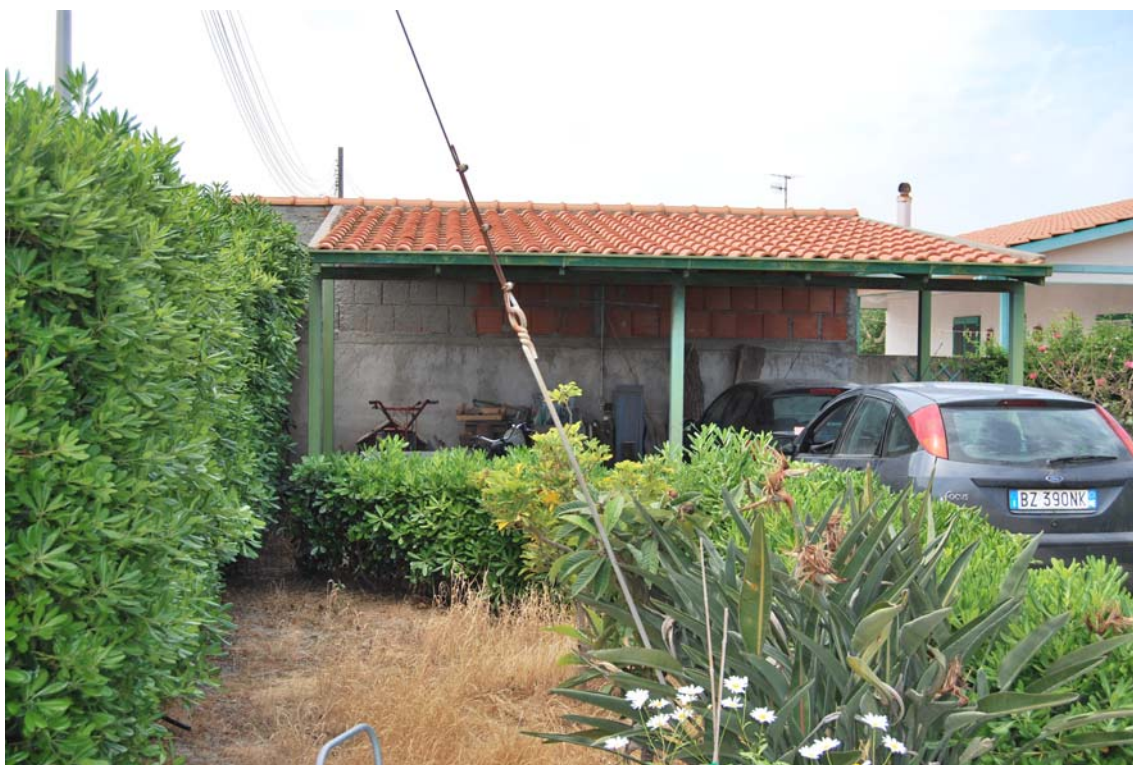
FOTO VISTA LATO EST (TETTOIA)
