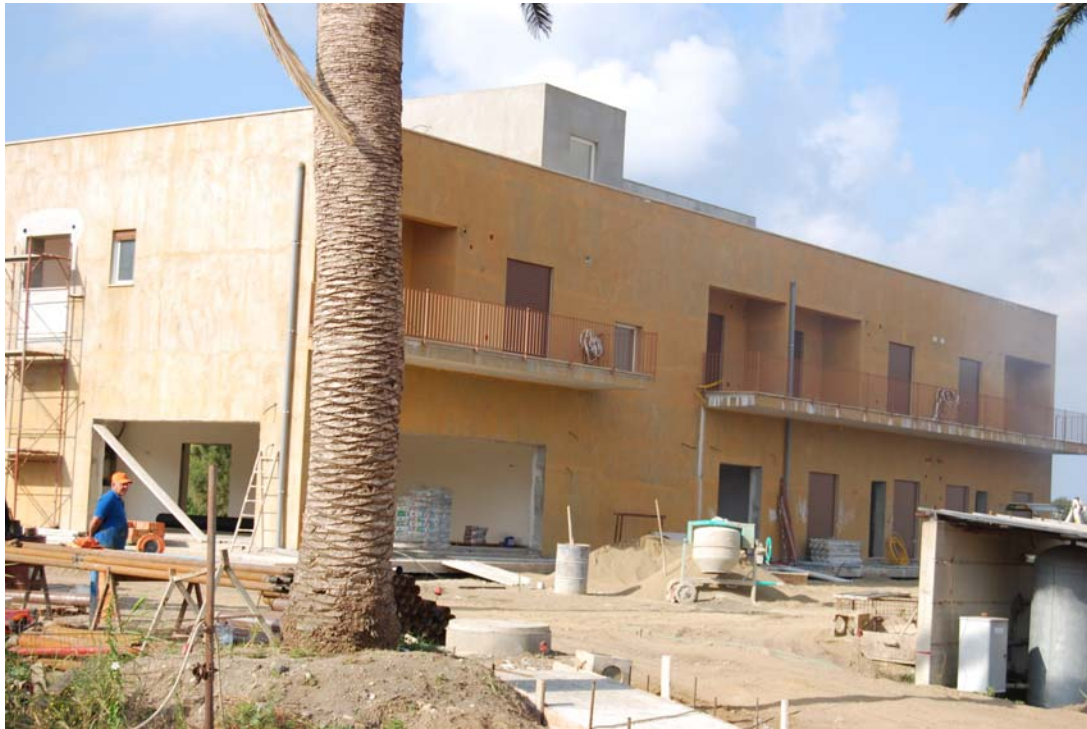
FOTO VISTA LATO SUD/OVEST
