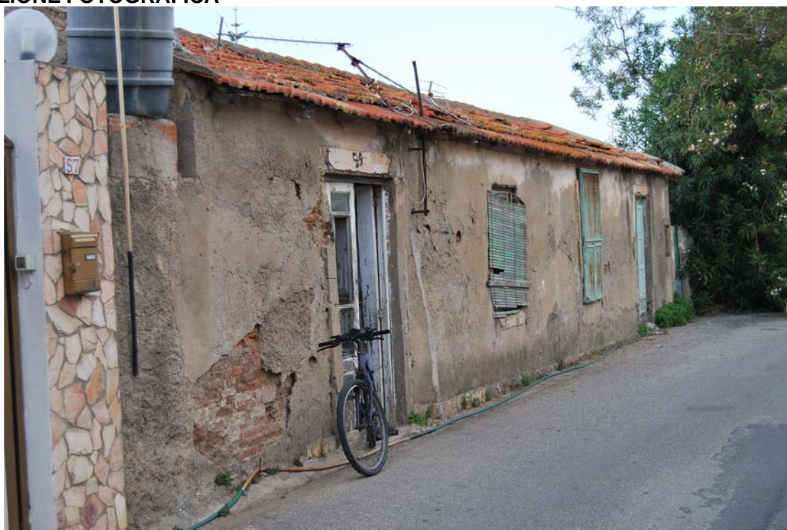
FOTO VISTA LATO S/O
