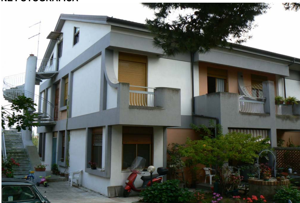
FOTO VISTA LATO NORD/EST
