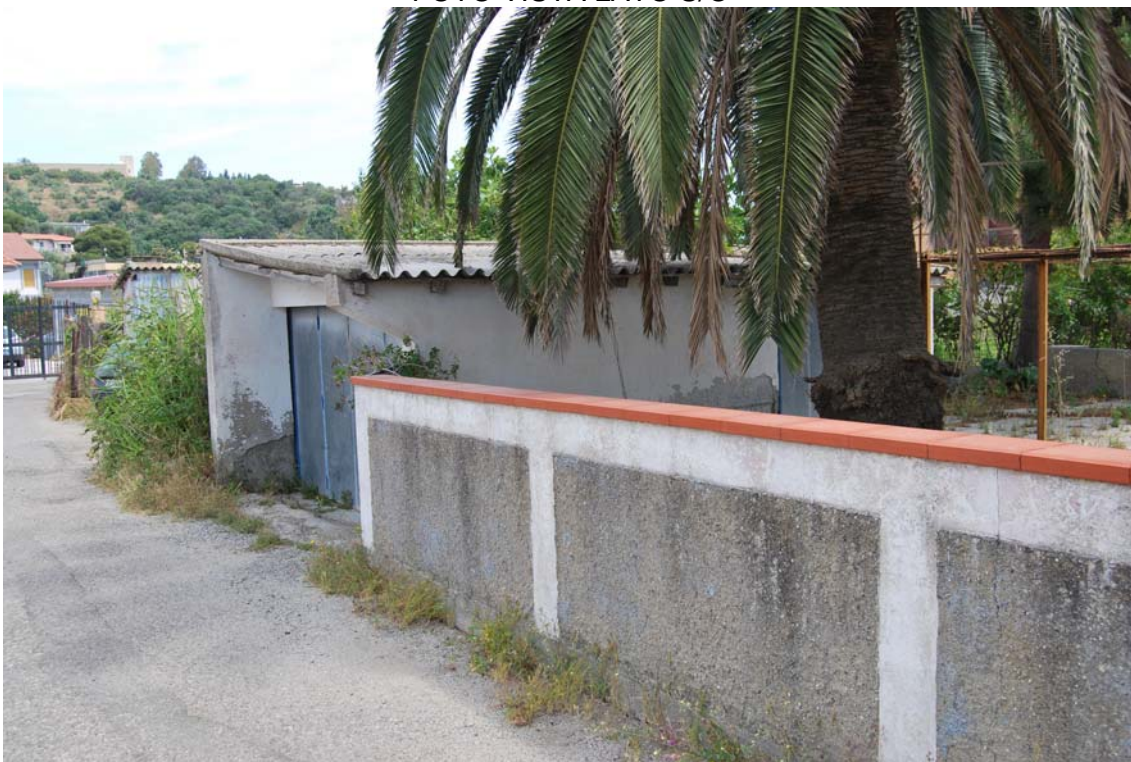
FOTO VISTA LATO S/O (S284)
